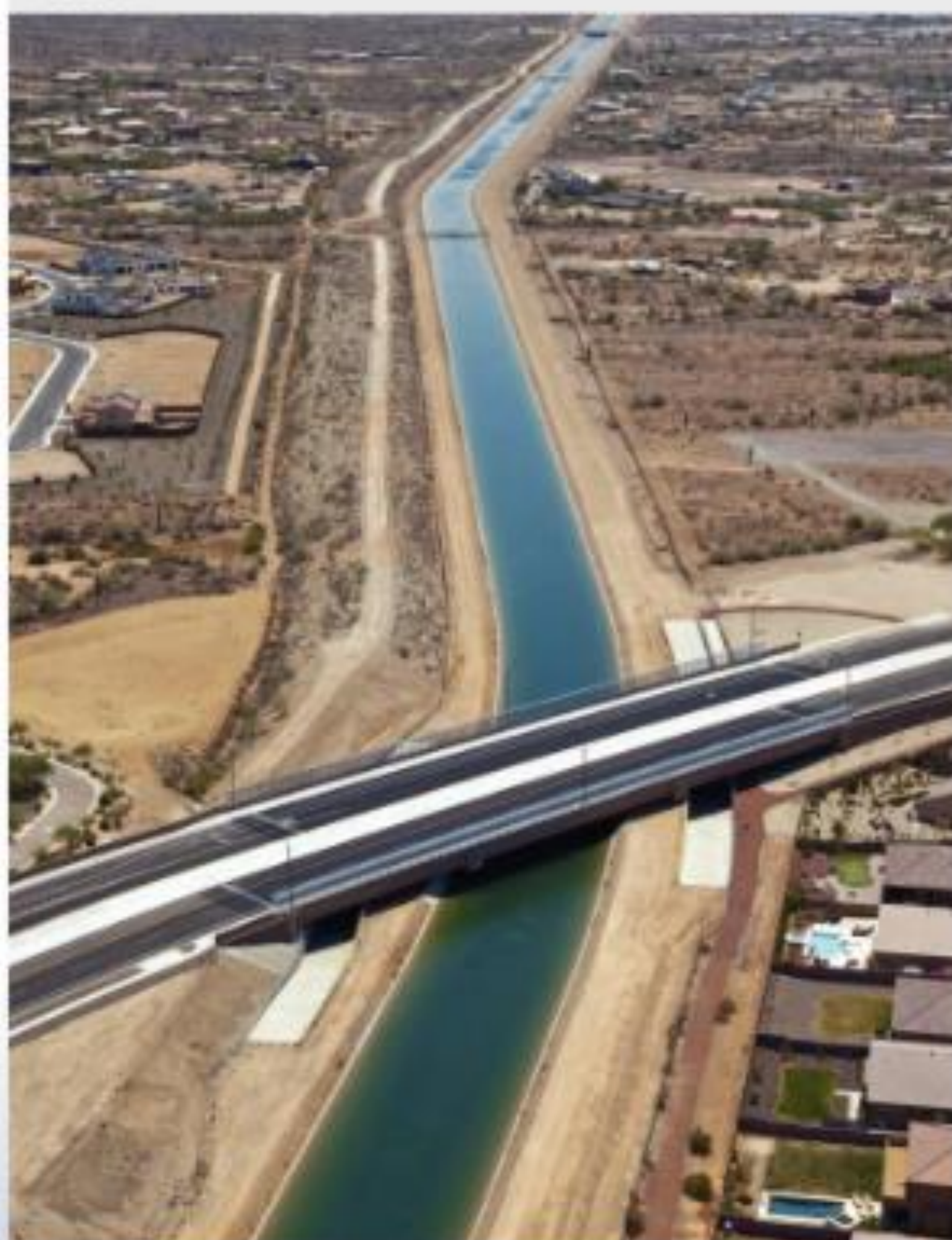
Een brug over het kanaal van het Central Arizona Project. Dit kanaal is 542 km lang en brengt water vanuit de Coloradorivier naar Phoenix en Tucson.
