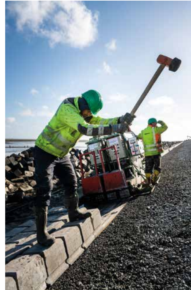
Aanleggen steenbekleding (Lauwersmeerdijk).
