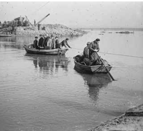
Burghsluis 1953. Dijkdoorbraak omdat het talud het begaf.
