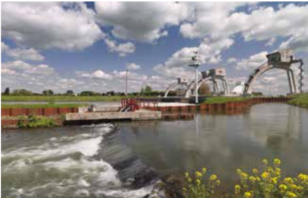
Vistrap bij het stuwencomplex bij Hagestein, waardoor de vissen omhoog kunnen zwemmen bij gesloten stuw.
