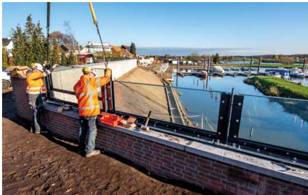
Het plaatsen van de glazen elementen (Neer).
