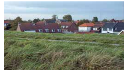
Hoe versterk je de dijk en houd je rekening met alles wat er direct achter de dijk ligt? (Hansweert)
