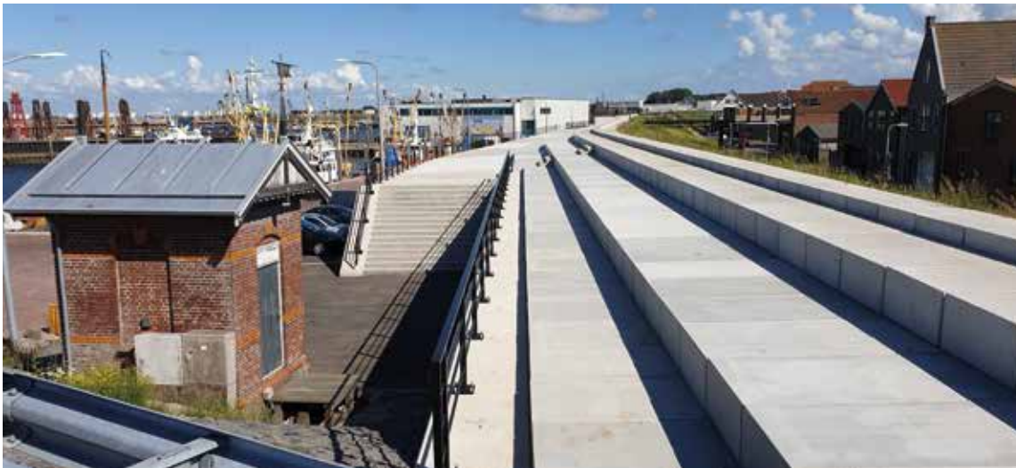
Getrapte dijkbekleding in de haven van Den Oever zodat bezoekers kunnen uitkijken over de haven.
