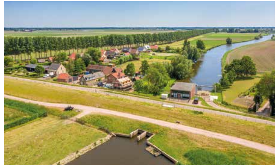
Gemaal als kunstwerk in de waterkering bij Tonnekreek.
